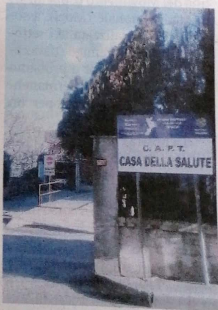
L'ex ospedale I servizi sanitari risultano inadeguati
